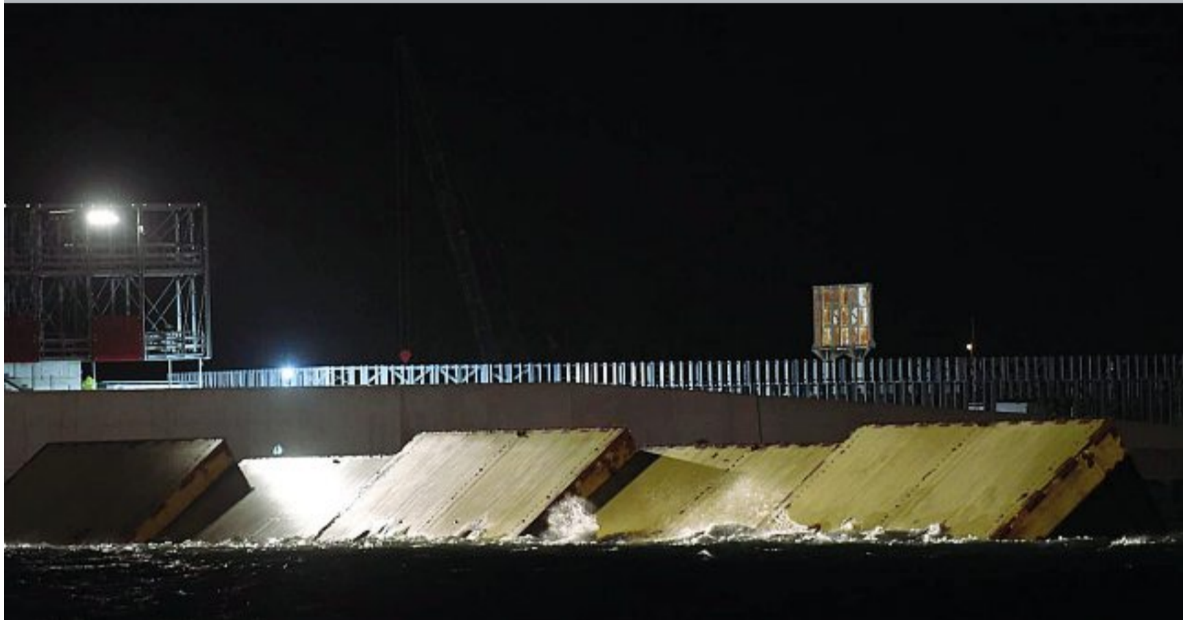
Suggestiva Le paratoie del Mose che sono state alzate ieri sera alla bocca di porto di Malamocco. Si è trattato di una prova con le dighe mobili che dovranno salvare Venezia dall'alta marea
